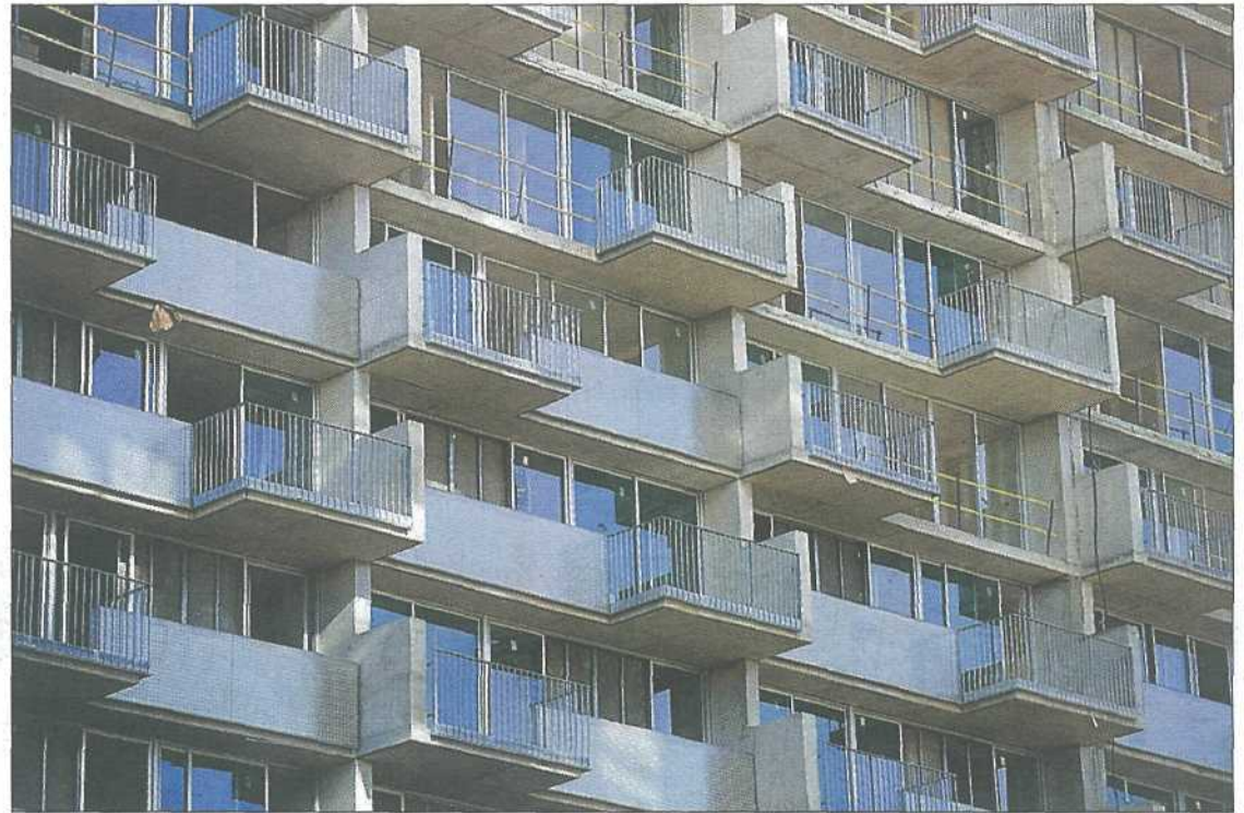
Pisos sociales en construcción en el Poblenou de Barcelona.
